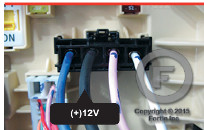
② Front of the use box. Au devant de la boîte à fusibles.
