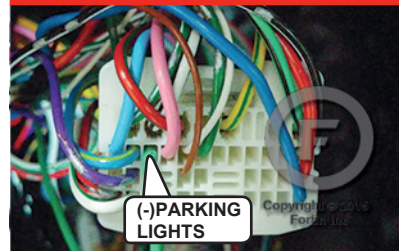
② BCM Behind fuse box BCM À l'arrière de la boîte à fusibles
