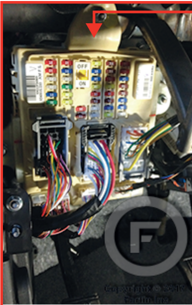
③ Fuse box Boîte à fusibles
