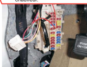
⑥ Fuse box driver kick panel. Boîte à fusible panneau latéral chauffeur.
